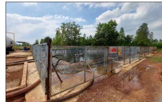
ตัวอย่างบ่อ Cement Pit( บ่อรับน้ำปนเปื้อน )ที่ฐานผลิต BMS 2
